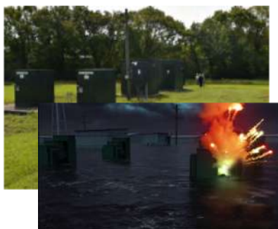
2-Las aguas alcanzaron los transformadores eléctricos principales de la planta y se perdió la electricidad.
